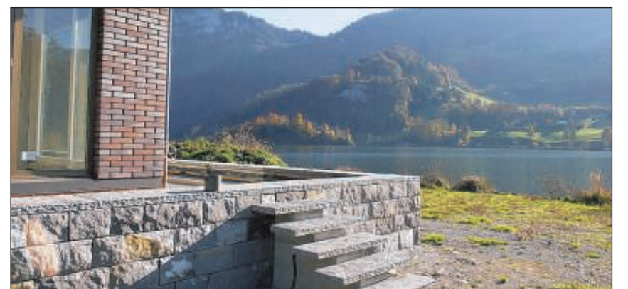
Alle Vorsorge nützte nichts: Auch Bauten, die nach dem Hochwasser 1999 in Lauerz angehoben worden sind, standen diesmal wieder im Wasser.
