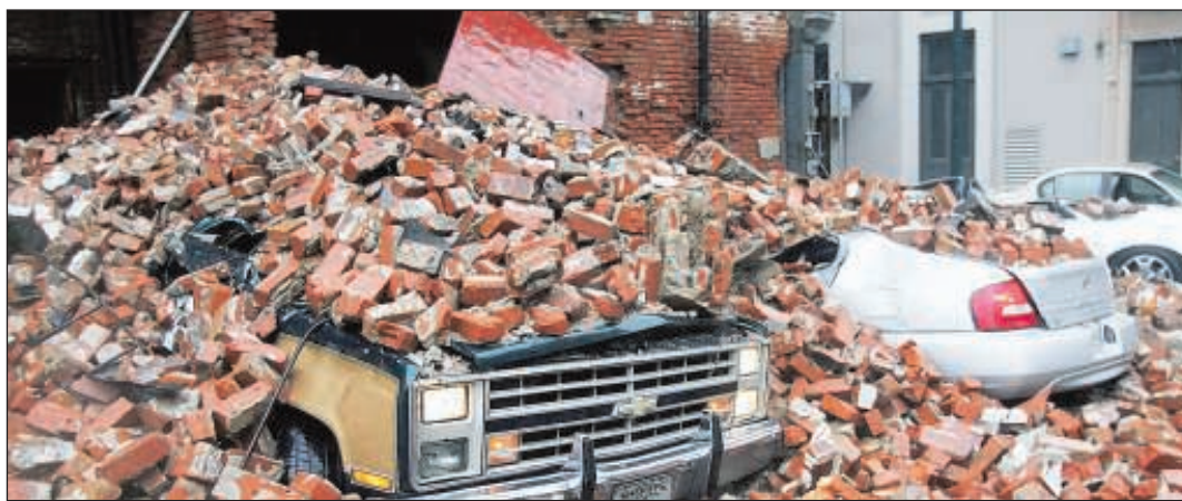
Hoher Schaden: Zahlreiche Häuser, Autos und Strassen wurden durch den Hurrikan beschädigt.
